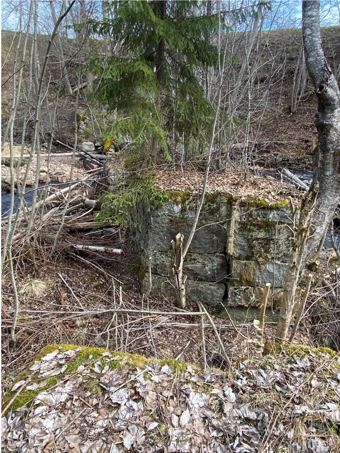
Fundament efter dammlucksstrukturen nordväst om byggnaderna.
